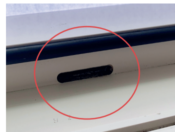
Afbeelding ontwatering sleuf binnenzijde.
