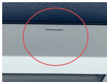
Afbeelding ontwatering sleuf buitenzijde.
