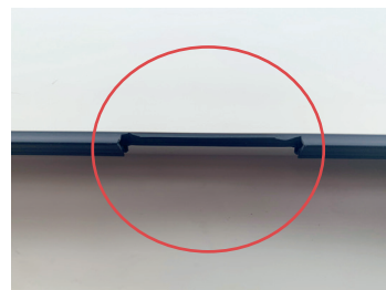
Afbeelding beluchting dmv rubberdichting onderbreking.
